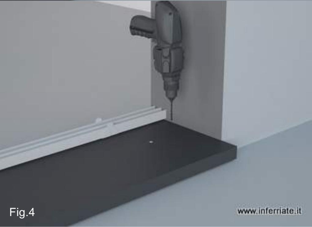
Fig. 4 Effettua i fori utilizzando un trapano tassellatore con punta da muro diametro 8 mm.
